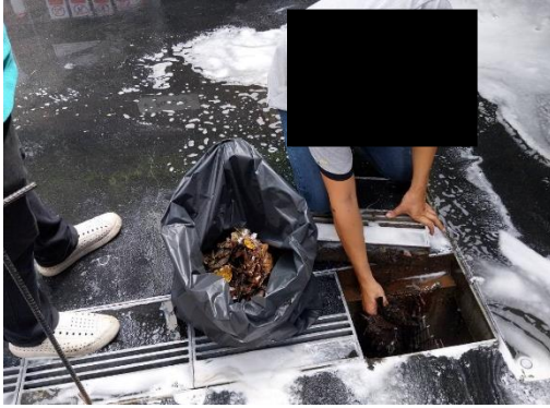
ภาพที่ 2.2-17 เจ้าหน้าที่ลอกท่อระบายน้ำบริเวณพื้นที่โครงการ
